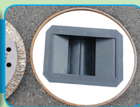
하수 악취 차단장치 설치
