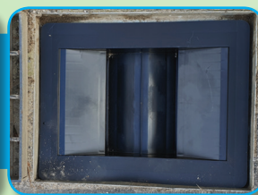
하수 악취 차단장치 설치
